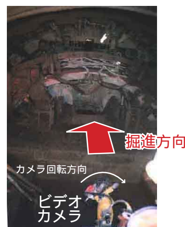
写真1 坑壁撮影状況
