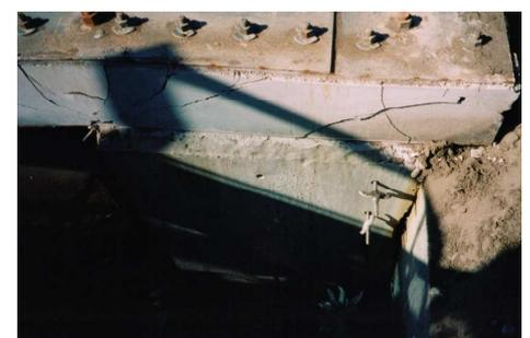
写真-2 頂版と壁の接合部の損傷
