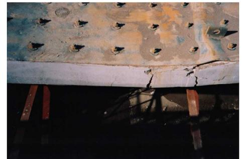
写真-1 頂版中央部の損傷
