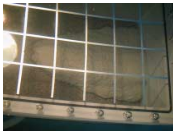
写真 1 スラリーの充填状況
