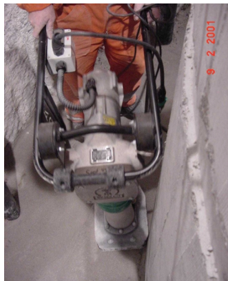
図-3 充填材の締固め状況
