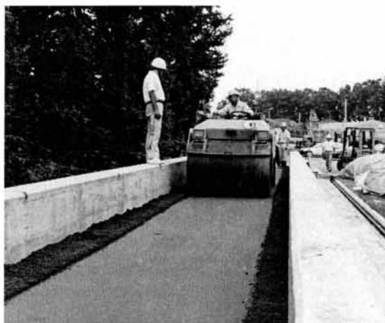
図2 ベントナイト系外周充填材の試験施工
