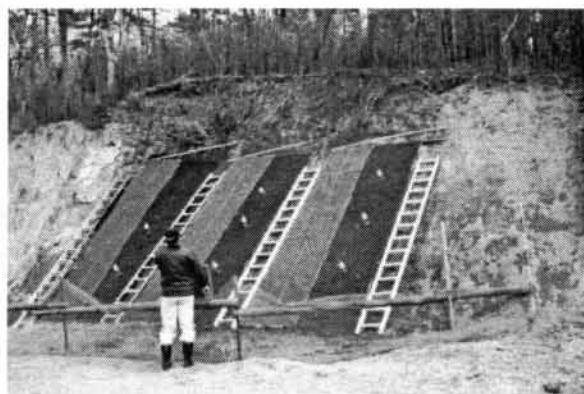
写真-1 吹き付け直後
