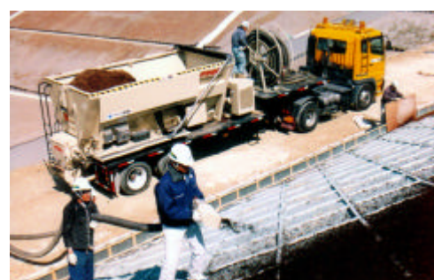
写真4 ブロー式チップ吹付機
