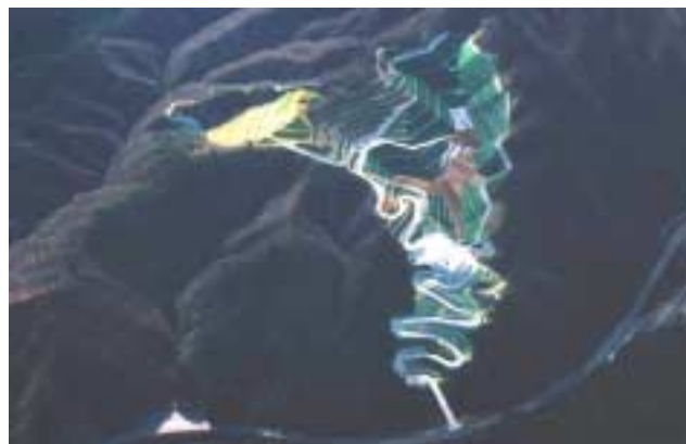
図-2 処分場全景
