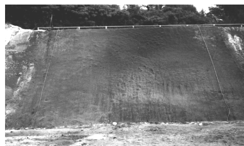
写真 - 1 遮水材吹付け後の全景 (九州地区 A 処分場)
