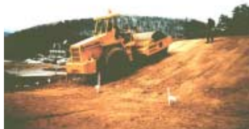
図-4 施工試験の状況
