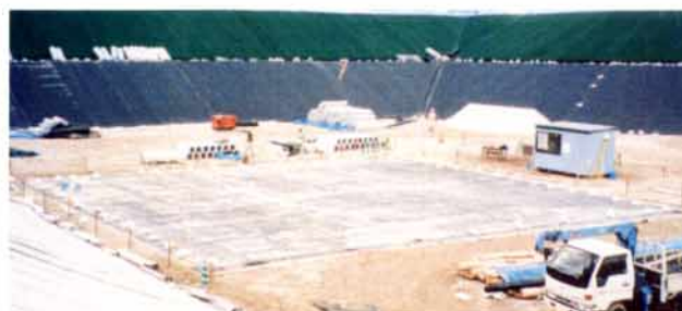
写真－1 実証実験全景
