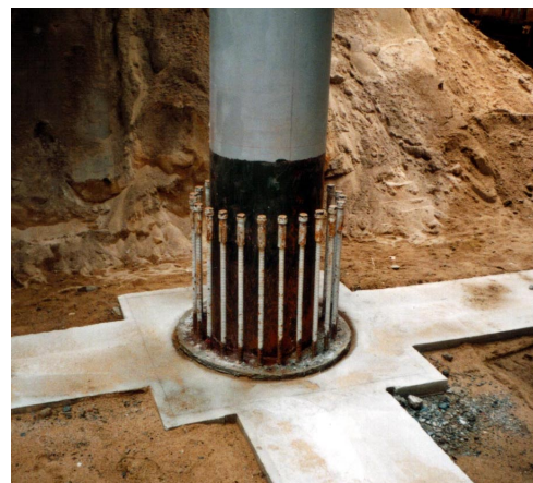
図 4 杭頭はつり後の杭主鉄筋と CFT 柱
