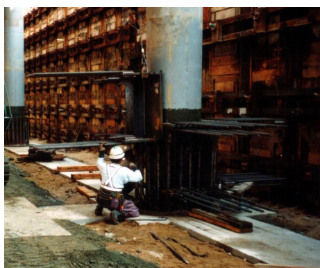
図 5 ソケット鋼管建て込み据付状況
