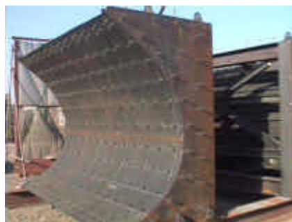
写真-1 鋼殻写真 (施工手順 2)
