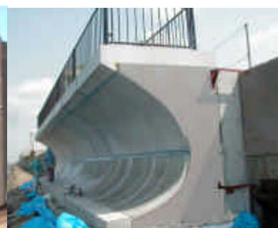
写真-2 護岸設置状況 (施工手順 8)
