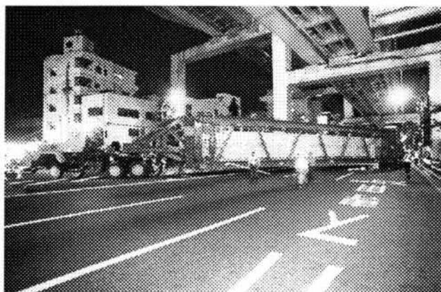
図-4 桁の運搬状況
