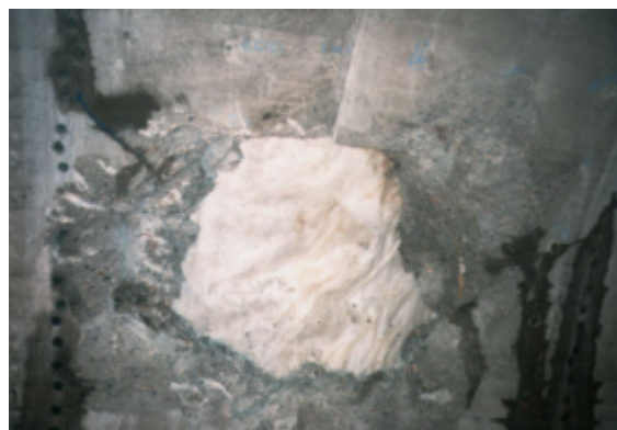
図-4 放電衝撃破砕による覆工破壊状況
