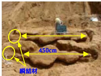
写真-5 掘出し状況 1
