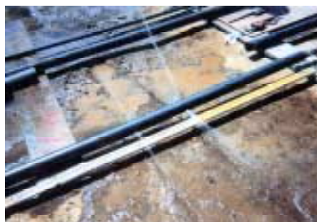
写真-4 注入イメージ(鋼管より)
