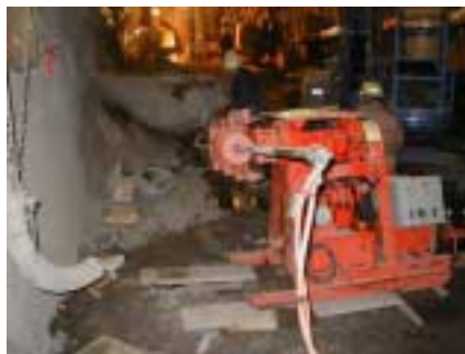
写真-1 注入状況
