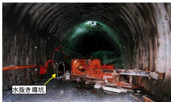
写真-2 大量湧水対策工（大口径ボーリング）
