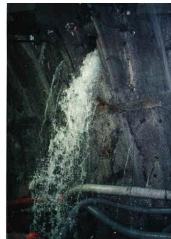
写真 - 1 突発湧水状況
