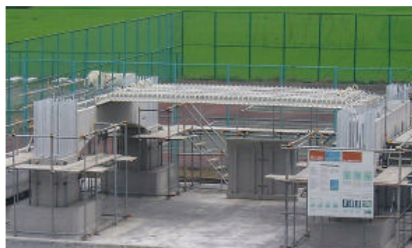
(c)ハーフプレキャスト梁・スラブ架設完了
