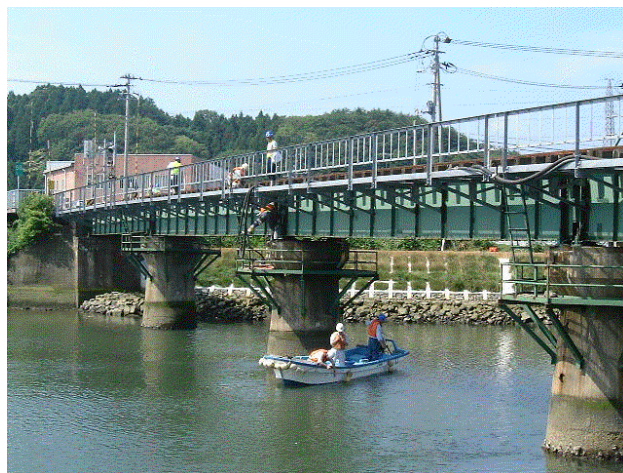
写真-1 J R 気仙沼線第3大川橋梁(施工状況)
