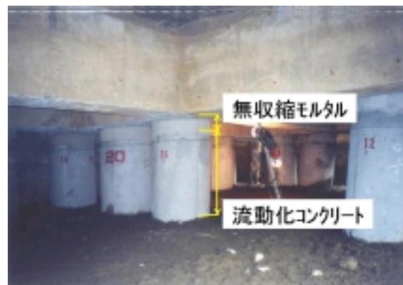
写真 - 1 コンクリート打設完了
