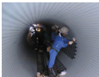
写真2 表面部材組み付け
