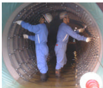
写真1 鋼製リング組立
