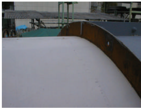
写真4 裏込め材充填状況
