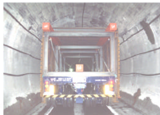
写真 - 3 防護シェルター設置状況写真
