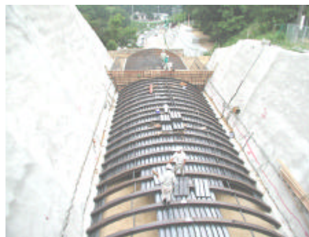
写真 - 2 上部支保工設置状況
