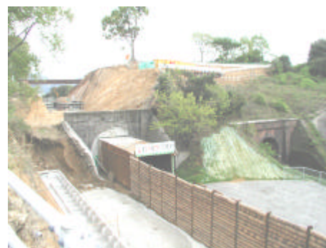
写真 - 4 防護シェルター設置完了
