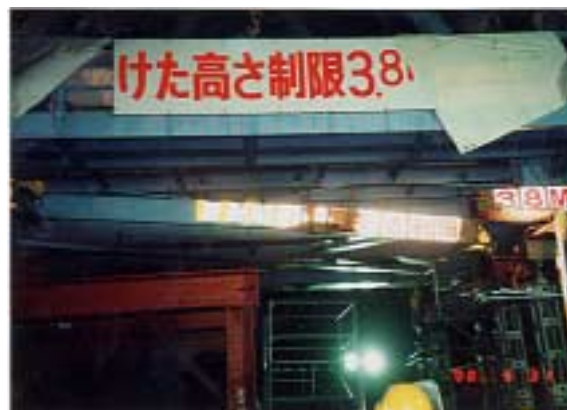
写真-2 下弦材取替状況
