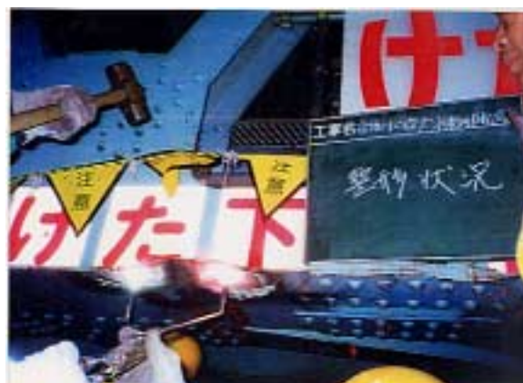
写真-3 加熱矯正状況
