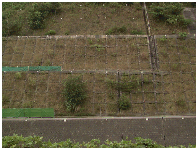
写真-1 標点の設置状況
