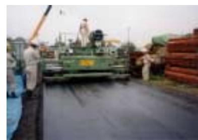
写真－1 施工状況
