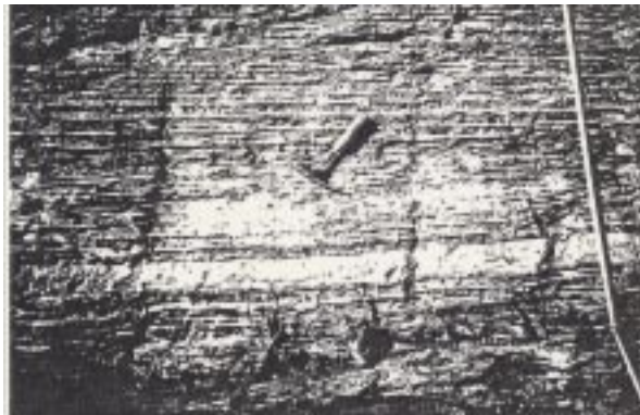
写真-1 掘削面の地質状況
