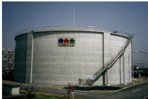
写真-1 完成全景
