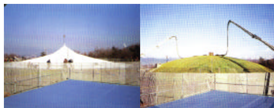
写真-2 エアドーム工法
