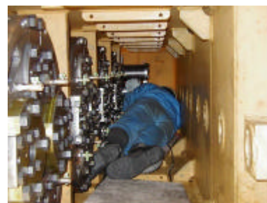
写真-4 スポーク内作業状況 （バルブプレート型）
