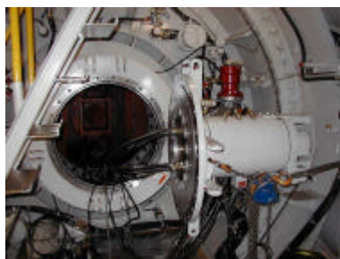
写真-3 スポーク内出入口
