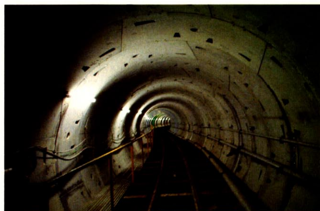
写真－2 坑内の状況
