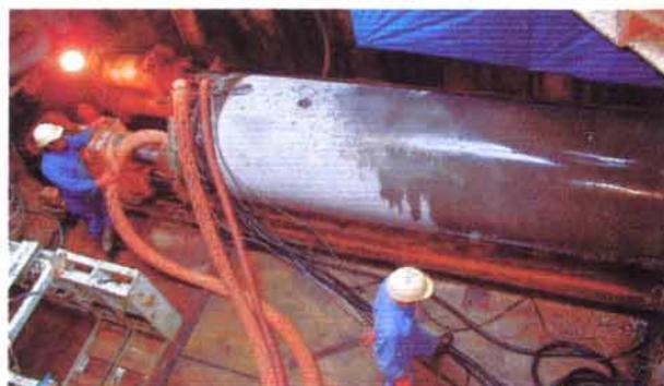
写真-1. 長尺推進管による推進状況
