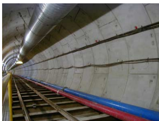
写真 -2 覆工完了
