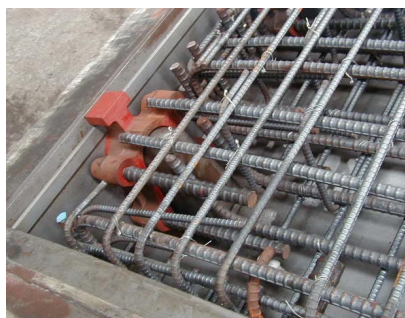
写真-1 継手廻りの配筋状況
