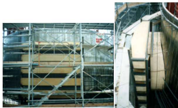
写真-1 発進部のFFU壁
