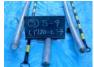
写真-2 グラウトC充填状況
