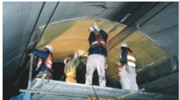
写真-2 アンカーピン打設状況
