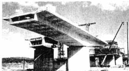
図1 天竜川施工状況
