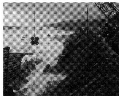
写真3 ブロック投入
