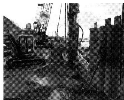
写真4 親杭打ち込み
