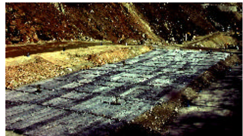
写真-1 CSGの保温養生状況
