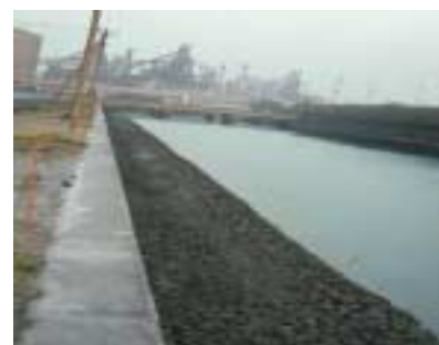
写真-1 根固め石の施工状況
