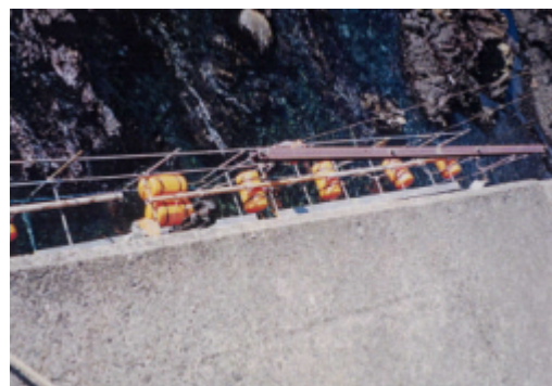
写真 - 3 配管切離し状況
