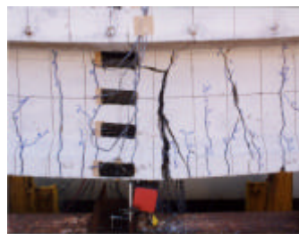
写真 4-1 曲げ載荷試験後の破壊状況
