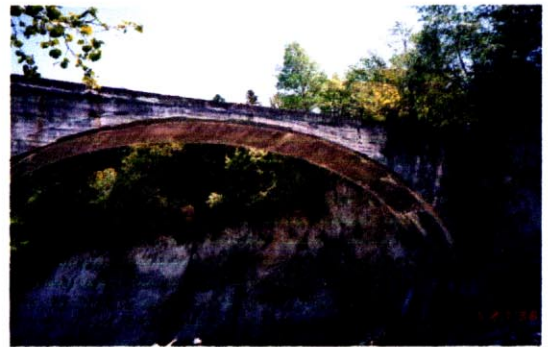
写真 3.1.1 解析対象の旧土幌線第六音更川橋梁
