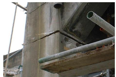
図4 試験終了時の打継ぎ目の状況
