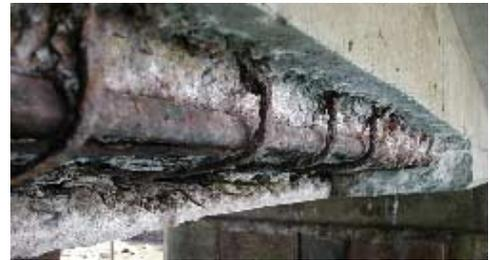
写真 - 2 鉄筋の腐食状況
