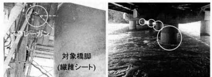
図-4 施工状況と経過状況
