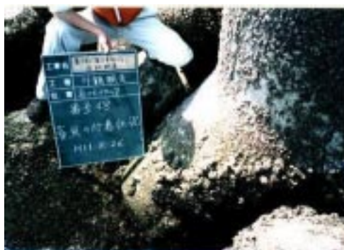
写真1 外観調査状況(据付1.5年時)
