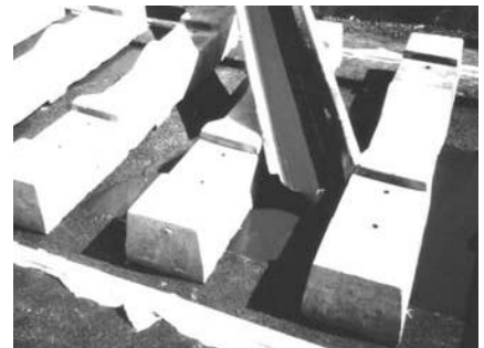
図 2 CA モルタルの注入状況
