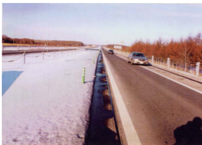
写真－1 路面溝切り工施工後の様子
