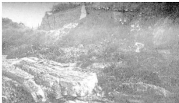
図4 石積擁壁の崩壊状況<sup>4)</sup>
