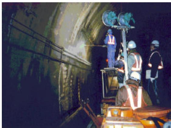
写真- 2 洗浄試験実施状況
